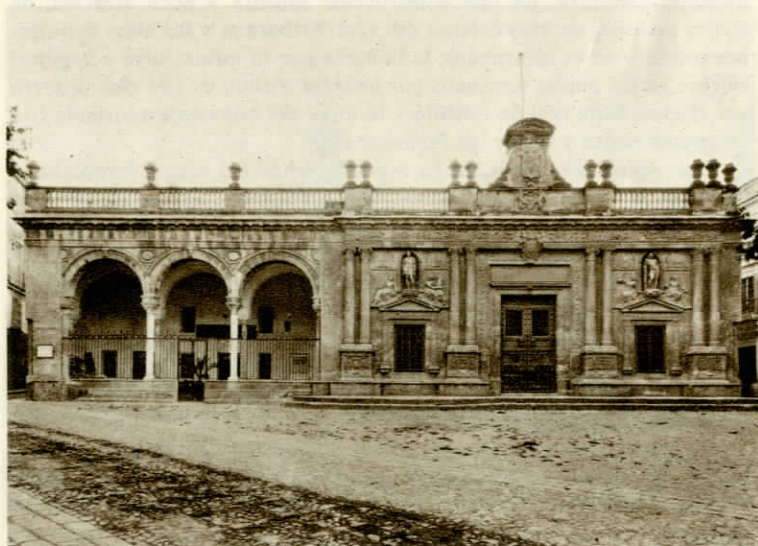
Fachada de la Biblioteca Municipal
