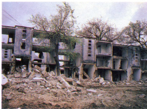
Demolición de la Bda. la Guita.
