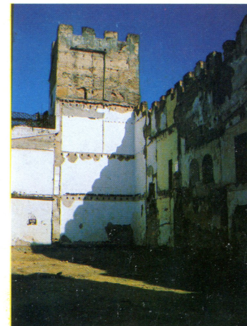
En estos 4 años, se ha empezado a dejar descubierto varios lienzos de la antigua muralla de Jerez.
