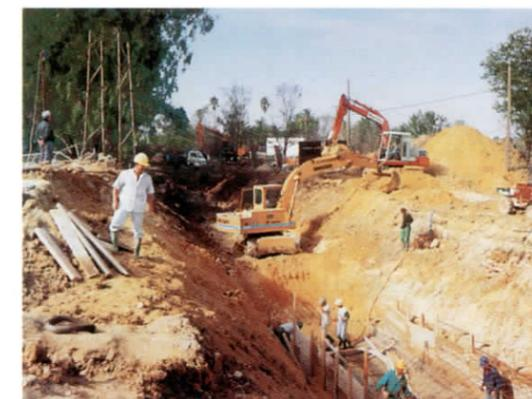
Dicha obra tiene una segunda utilidad básica, que es la de provocar la salida del agua en este punto ante cualquier tipo de obstrucción o manipulación no deseada a lo largo de los 6 km de longitud del Colector General 2ª Fase.
