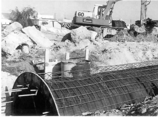
Las obras comprenden la ejecución de una serie de sumideros para aguas pluviales de 1,0 \* 0,6 metros de superficie de captación con rejilla y doble buzón.
