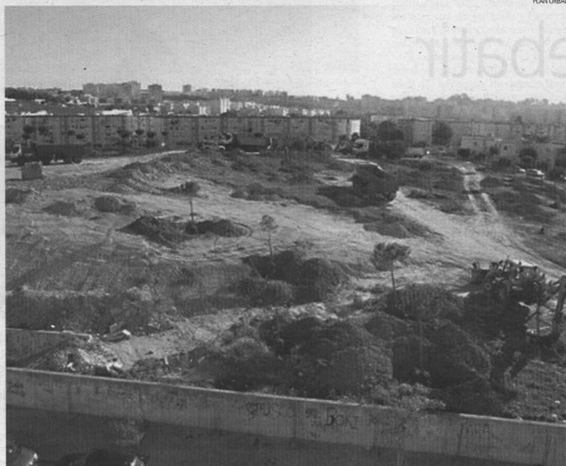
En septiembre comenzó el desmonte del Cerro de Santo Tomás, que ya está al 70%.
