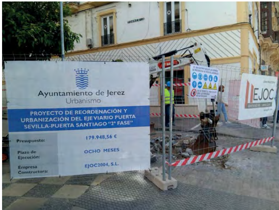
Estado actual de las obras de Primera Fase
