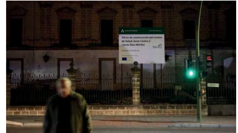
Imagen del estado actual de las obras
