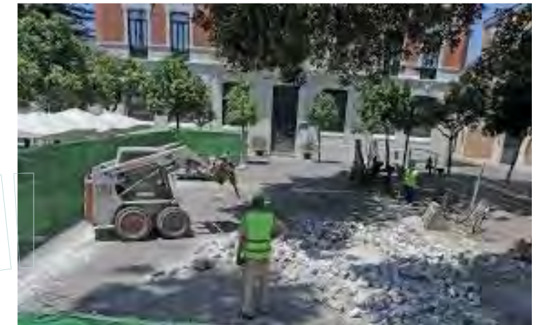
Imagen de la Plaza del Banco durante las obras EDUSI
