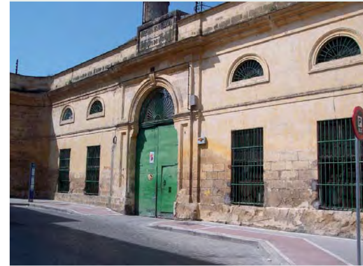
Estado actual del inmueble
