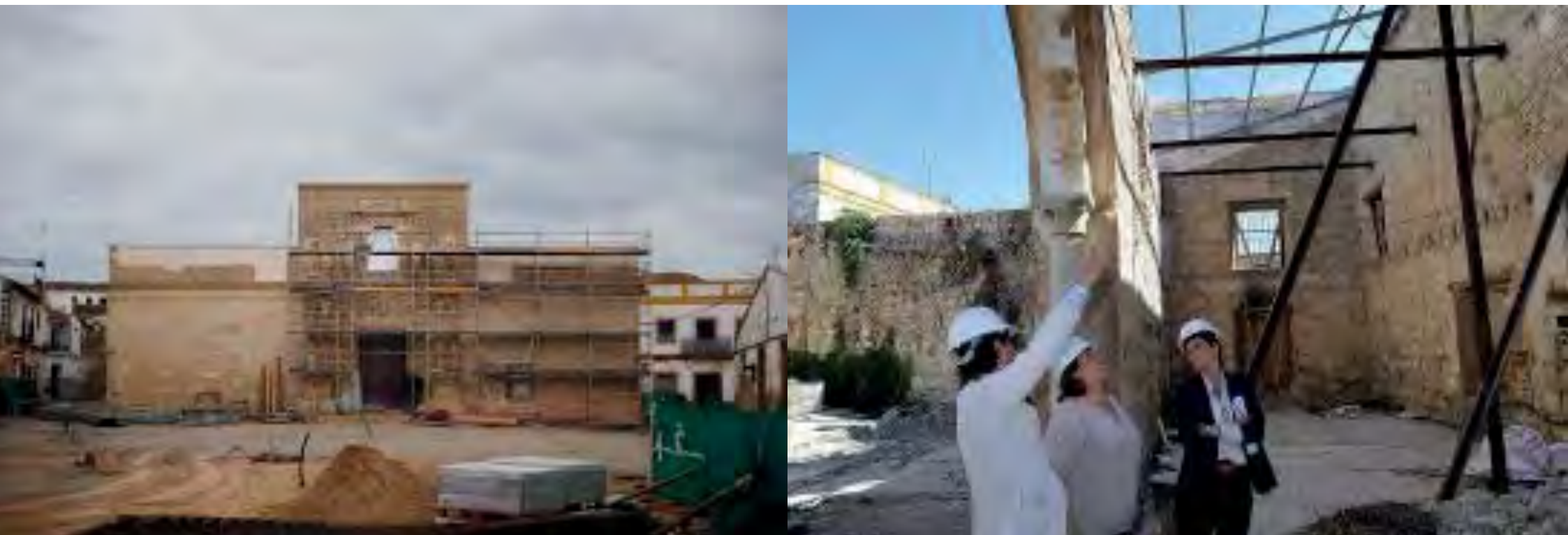
Imagen del estado actual de las obras
