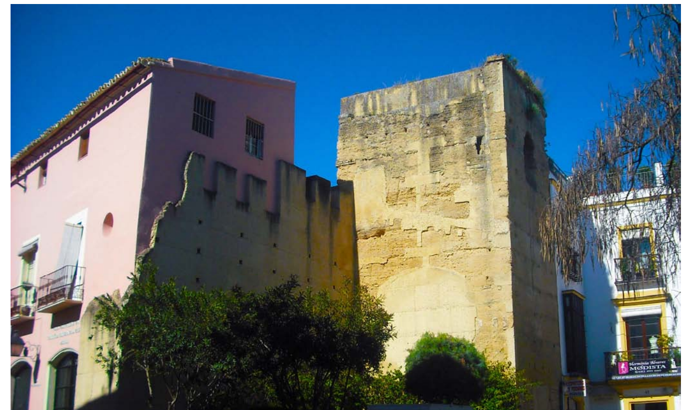
Lienzo torre de muralla con edificación adosada. Calle Porvera
