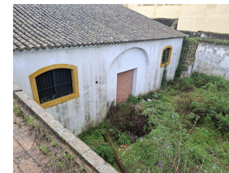
Fachadas interiores de la nave
