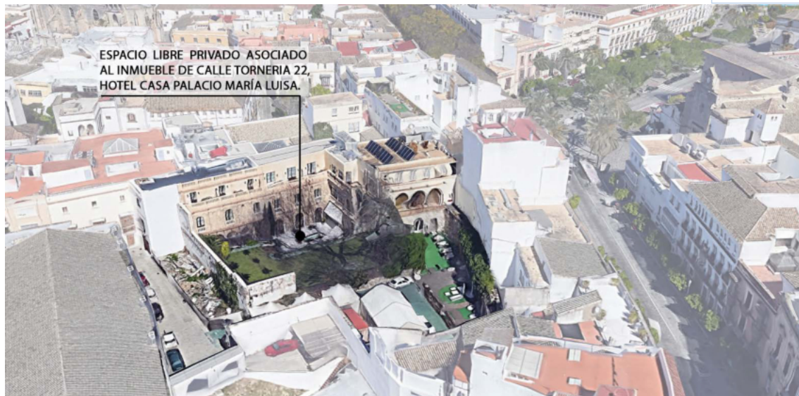
Imagen de localización del patio perteneciente a la Finca de Calle Tornería 22
