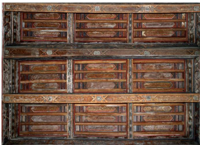
Fig. 16. Detalle alfarje del “Salón de las columnas.” Casa de Pilatos (fuente: Cabañeros, E, 2011)
