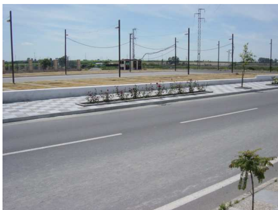
Foto 28. Carretera de Cortes
