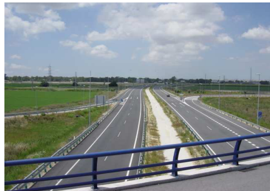
Foto 25. Carretera de Arcos
