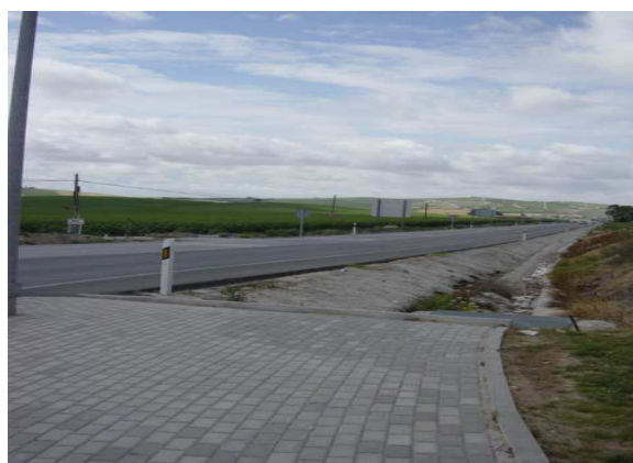
Foto 20. Carretera de Trebujena
